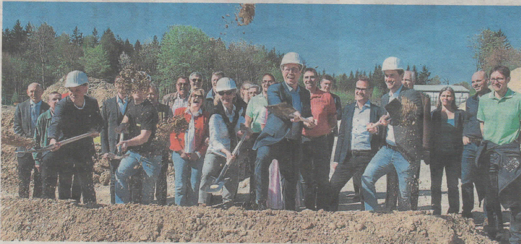
Der Bau kann losgehen: Bürgermeister Rainer Schnitzler beim Spatenstich.
